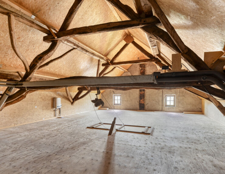
foto boven: bergzolder aan voorzijde woning
