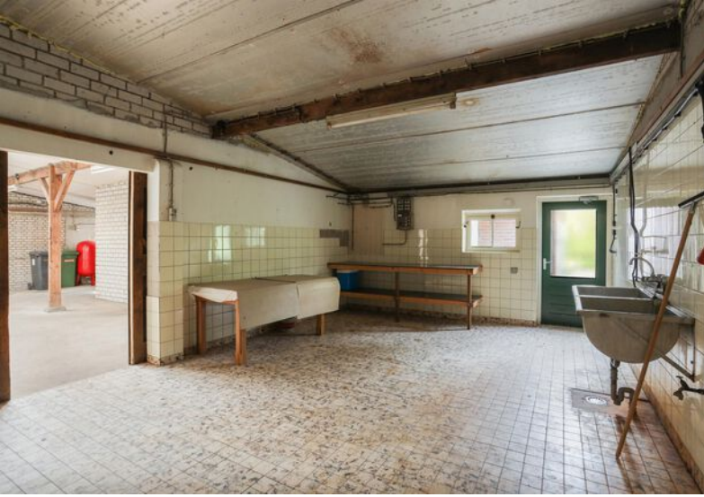
A: Aanpandige schuur, grenzend aan berging en melktanklokaal.
